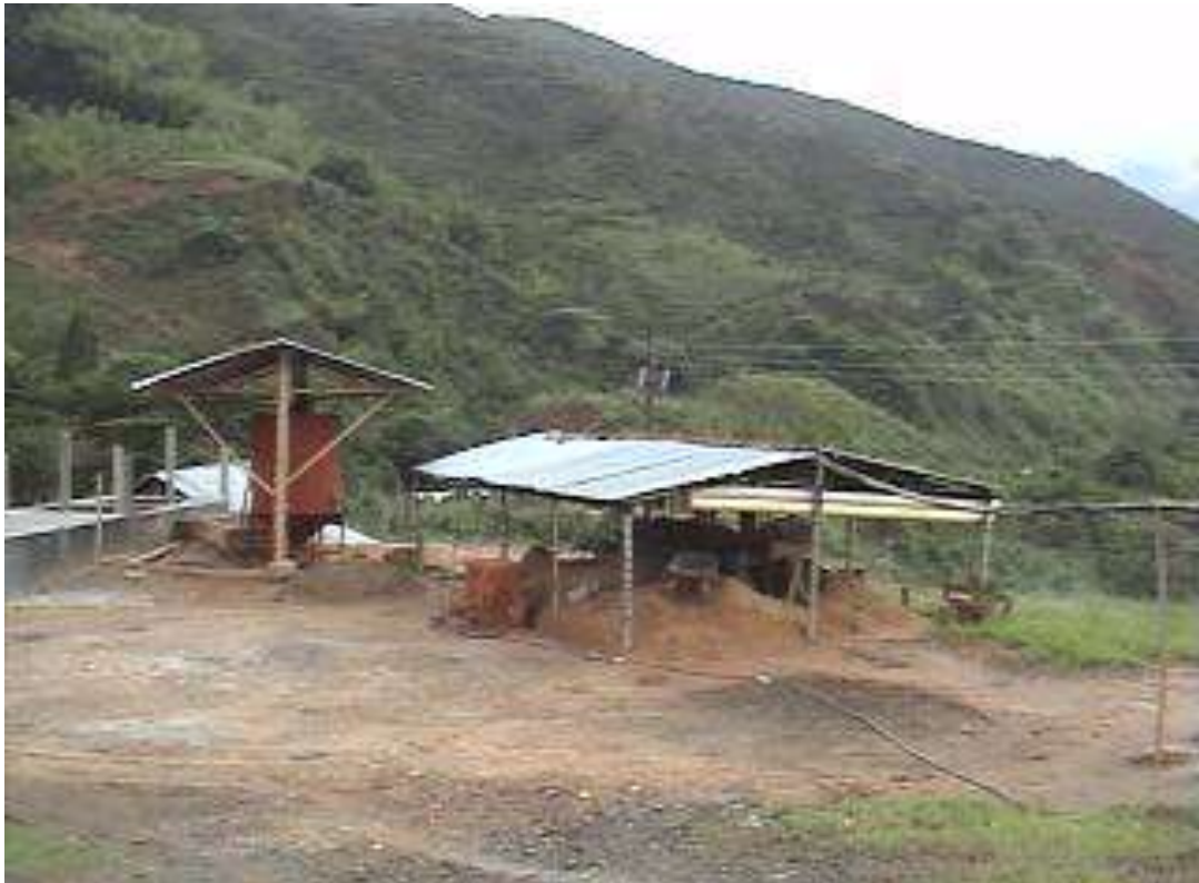
Foto No38 Planta de trituración , molienda , concentración gravimetrica ,cianuración y fundición Serví minas municipio de Suárez.
