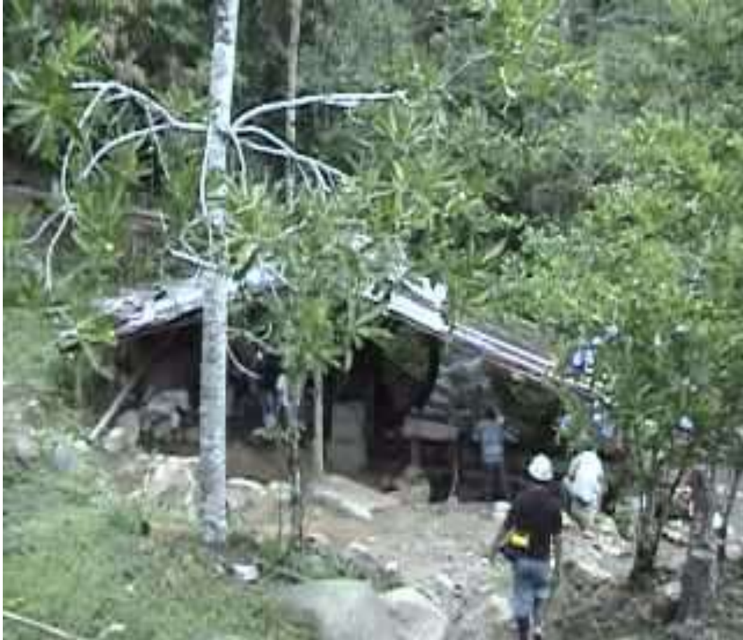
Foto No 24 planta de trituración, molienda, concentración gravimétrica y de cianuración los Acosta, vereda el Tamboral.
